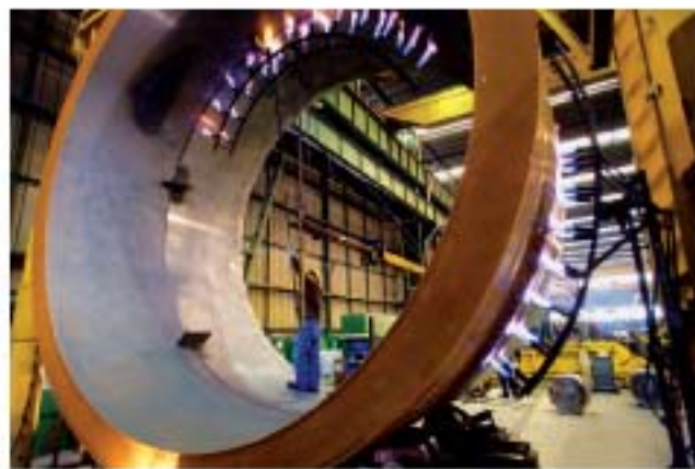
Saldatura ad arco sommerso di due virole di elevato spessore (328 mm)
