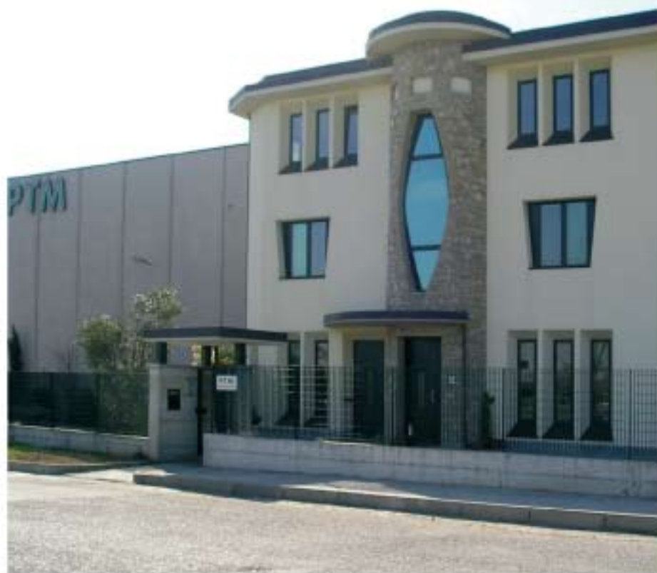
La P.T.M. di Castelli Calepio (BG) dispone di un parco macchine per lavorazioni di componenti di dimensioni medio-grandi destinati ai settori dell'energia, petrolifero, petrolchimico
